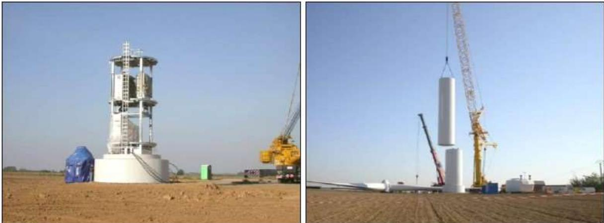
**Figure III.4-14 : Erection du mât d'une éolienne (source : Eneco Wind Belgium, parc éolien de Perwez)**
