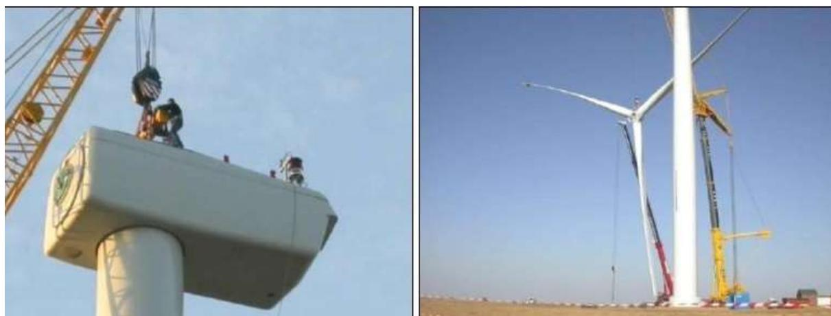
**Figure III.4-15 : Montage du rotor d'une éolienne (source : Eneco Wind Belgium, parc éolien de Perwez)**
