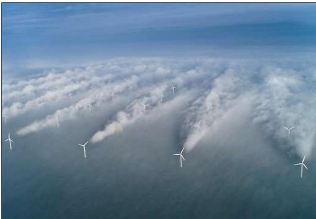
Figure IV.IV-12 : Effet de sillage sur le parc éolien en Mer du Nord d'Horns Rev (parc offshore, Danemark) (source : [www.eolienne.f4jr.org](http://www.eolienne.f4jr.org)).
