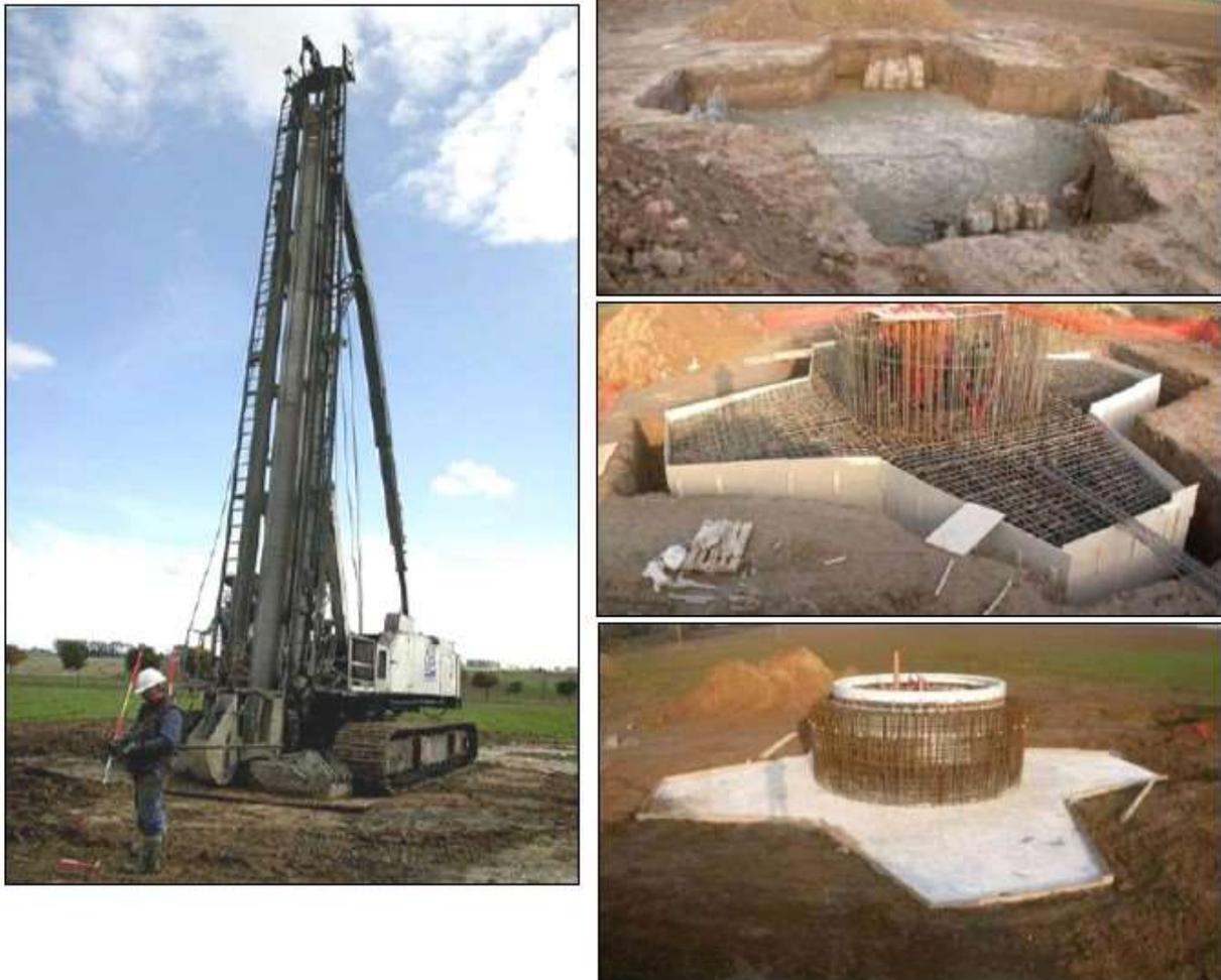
**Figure III.4-11 : Pose des pieux (figure de gauche) et différentes phases des travaux pour une fondation cruciforme (figure de droite) (source : Eneco Wind Belgium, parc éolien de Perwez)**
