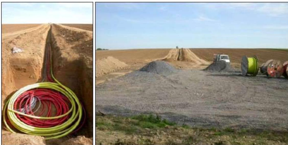
Figure III.4-18 : Pose de câbles de raccordement (figure de gauche) et aménagement d'une aire de montage (figure de droite) (source : Eneco Wind Belgium, parc éolien de Perwez)
