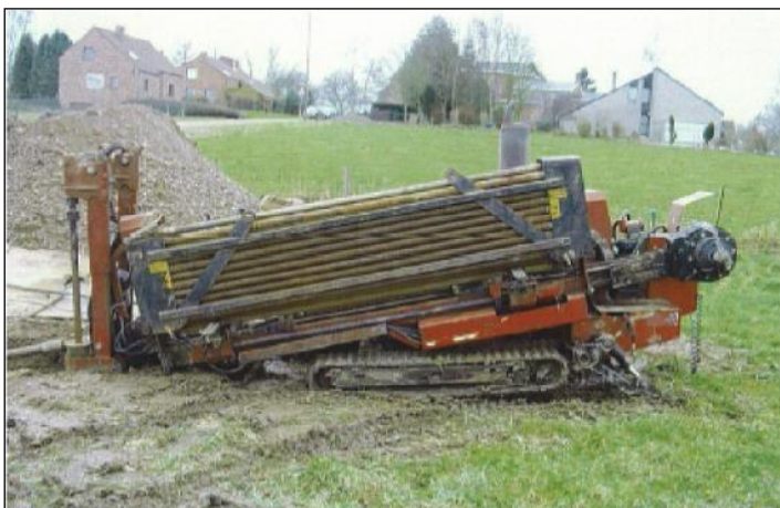
Figure 21 : Foreuse (source : Decube Consult, 2003).
