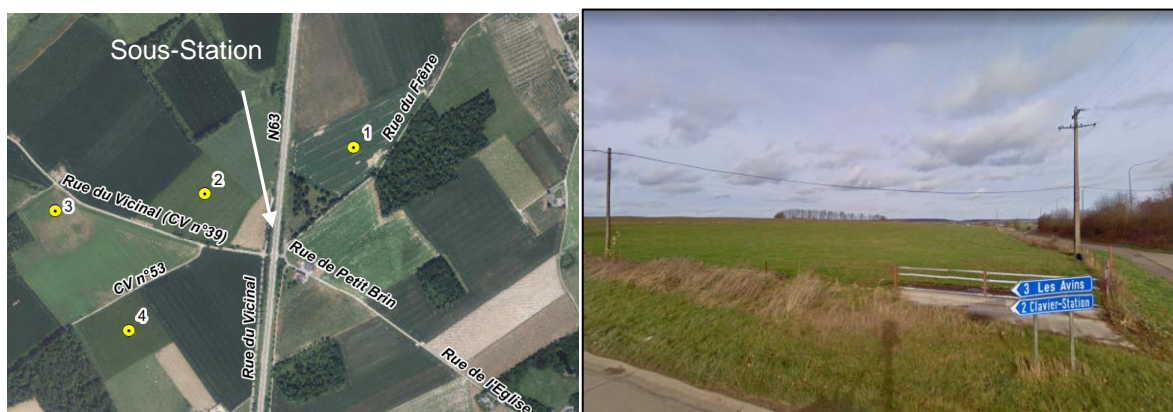
Figure 143 : Localisation de la sous-station
