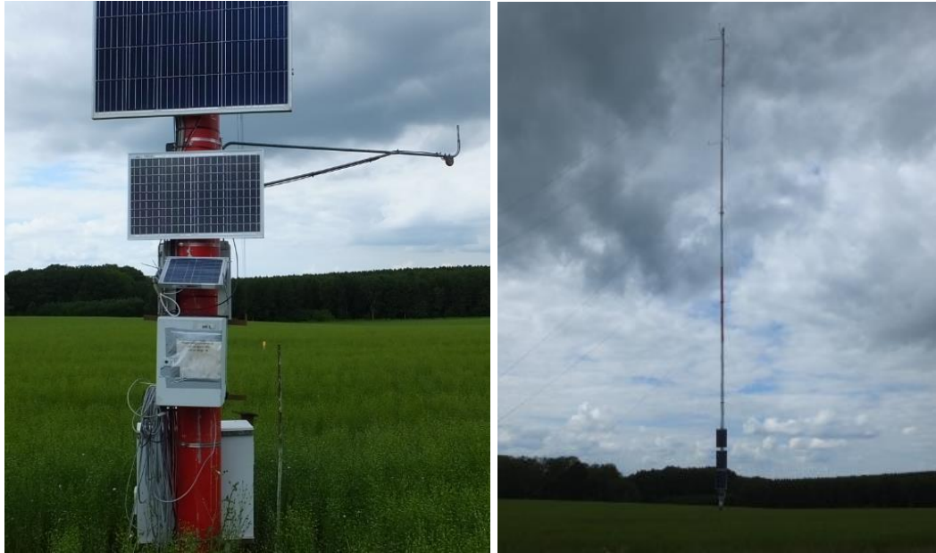
Figure 68 : Mât de mesure sur le site du projet éolien de Clavier.
