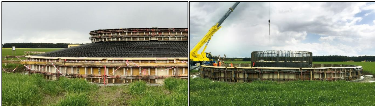
Figure 18 : Différents stades d'exécution d'une fondation cruciforme (source : Vortex).
