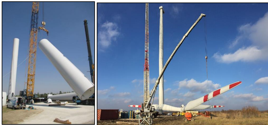
Figure 19 : Différentes étapes du montage d'une éolienne (source : Vortex).
