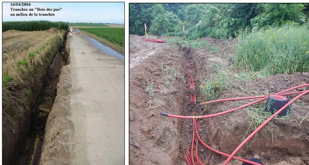
Figure 16 : Travaux de pose de câbles de raccordement (source : Luminus, parc éolien de Villers-le-Bouillet et de Héron, 2004 et 2016).
