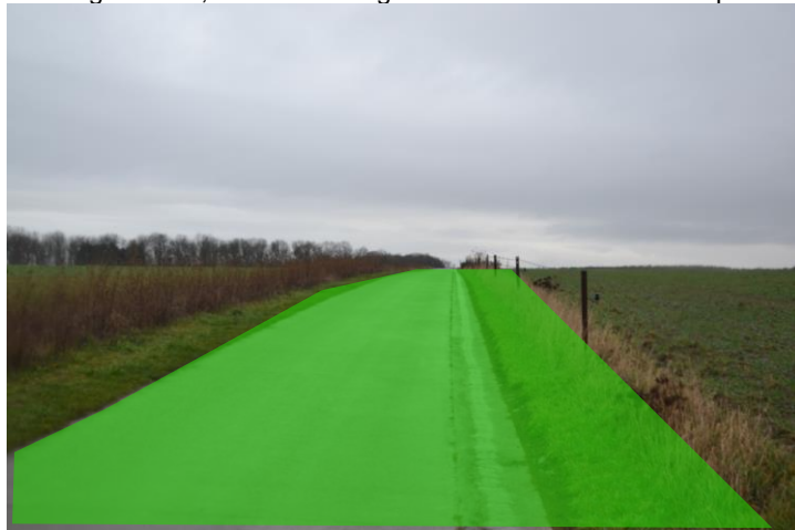
Depuis l'accès à l'éolienne 7 vers le chemin vicinal n°18
