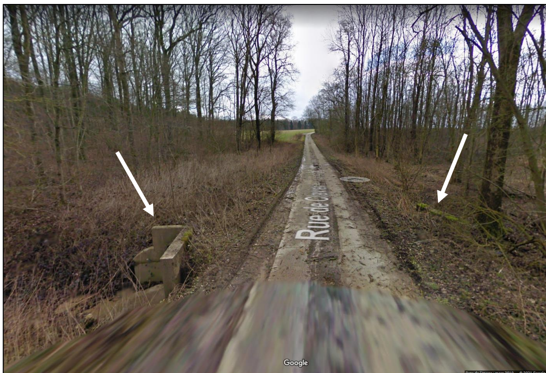
Figure 36 : Localisation du puits en béton situé sous le chemin vicinal n°58 entre les éoliennes n°5 et 6 (côté gauche et droit de la figure, voir flèches en blanc). La direction vers l'éoliennes n°7 est orientée dans le sens de la figure. (Google streetview, mars 2010).
