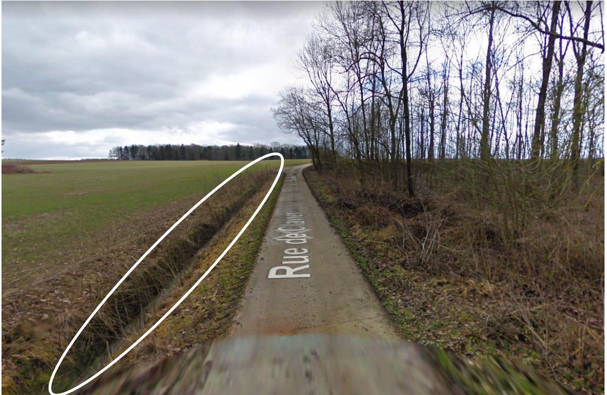
Figure 37 : Localisation du chenal en béton en "V" situé côté est du chemin vicinal n°58 entre les éoliennes n°5 et 6 (côté gauche de la figure). La direction vers l'éoliennes n°7 est orientée dans le sens de la figure. (Google streetview, mars 2010).
